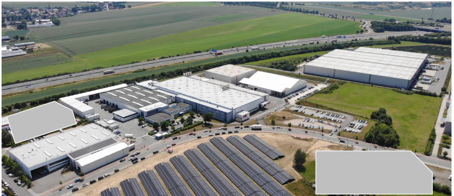
Bild 1: Werk Meerane der SMP Deutschland GmbH mit benachbarten angemieteten Hallen. Im Hintergrund verläuft die A4 Dresden-Frankfurt
